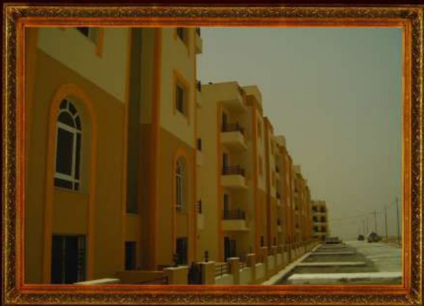
مقاطع من مدينة المجد قامت الشركة بتلييس أجزء الصناعي حول الشبايك و زوايا العمارات للمرحلة الأولى و عدد 56 عمارة
