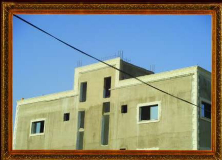
تلبسة الحجر الصناعي لروايا و شبايلك عمارة السيد احمد - تركيب شركة الرعي للحجر الصناعي الموقع جبل النصر
