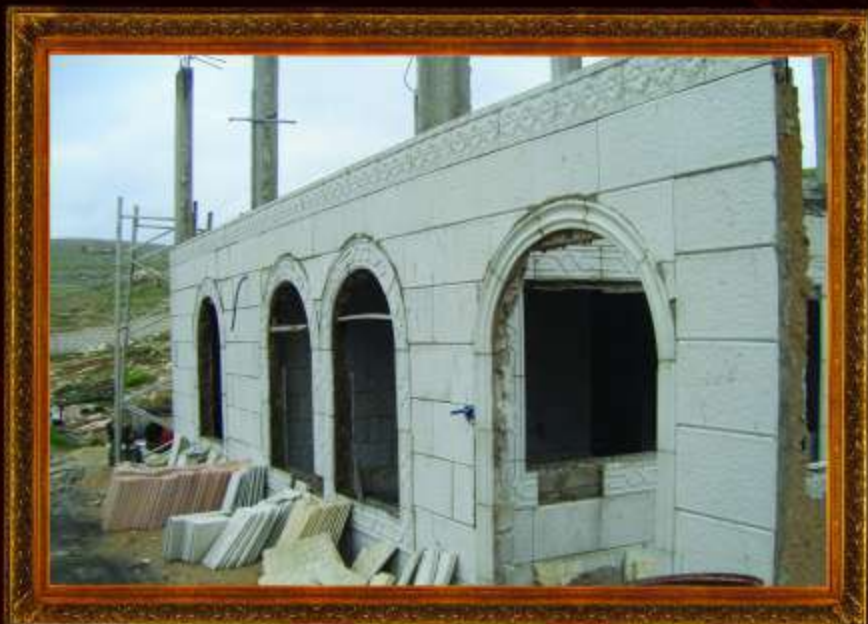
بناء يتم تلبسة بالحجر الصناعي - تركيب شركة الرعي للحجر الصناعي - الموقع غريسا
