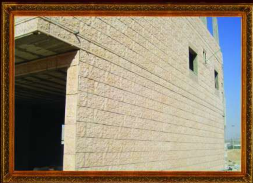
بناء قيد الانشاء يتم تركيب الحجر الصناعي له من قبل شركة الرعي الموقع : استيراد عمان - حي الجندري
